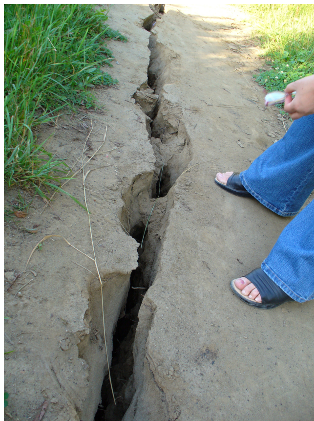
Рис. 8. Пос. Шебунино. Раскрытие трещины на берегу. Фото О.М. Шестаковой.
